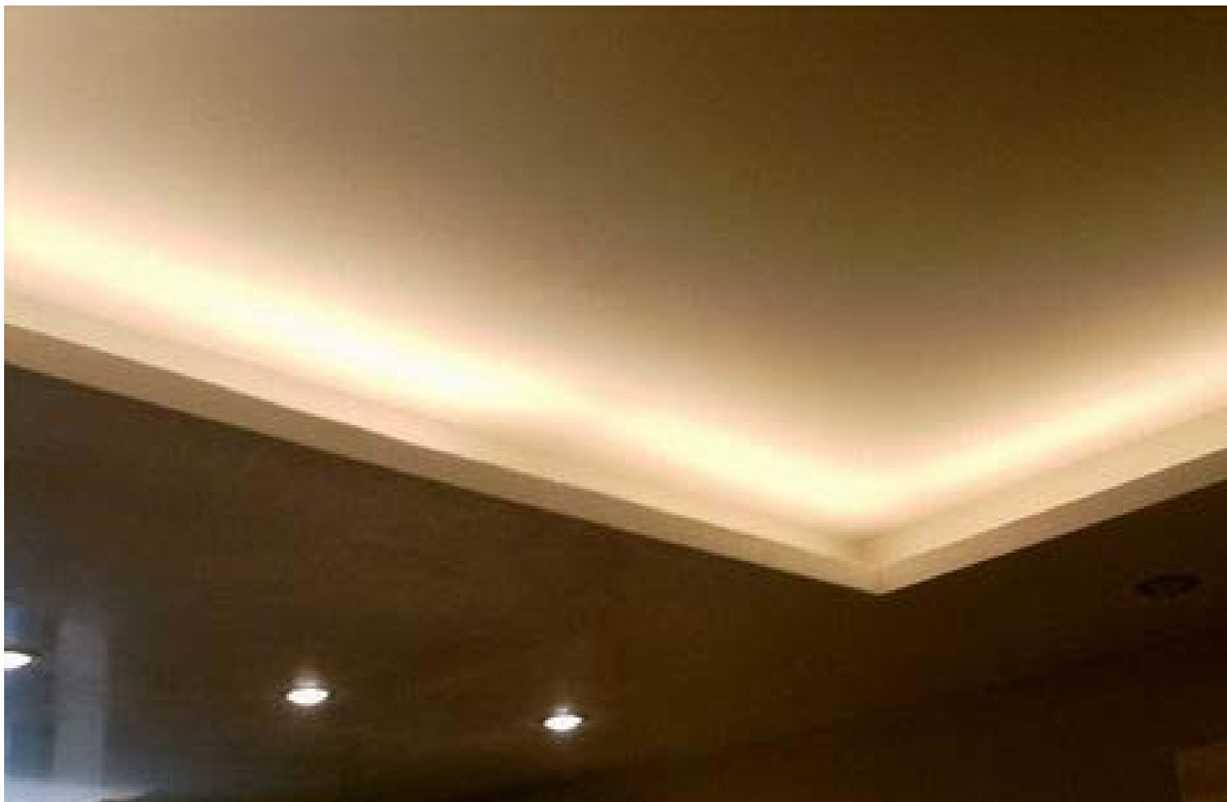
Esempio di effetto luminoso ottenuto con l'illuminazione indiretta del soffitto.
